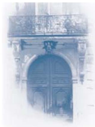
Source : site du MEN
